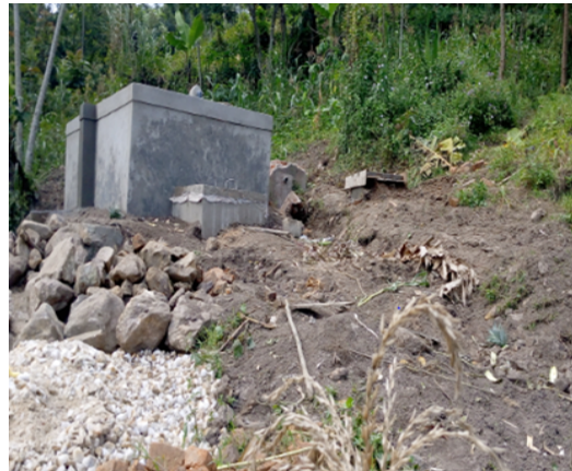
Foto de las entradas en el decantador de los caudales encontrados y decantador terminado
