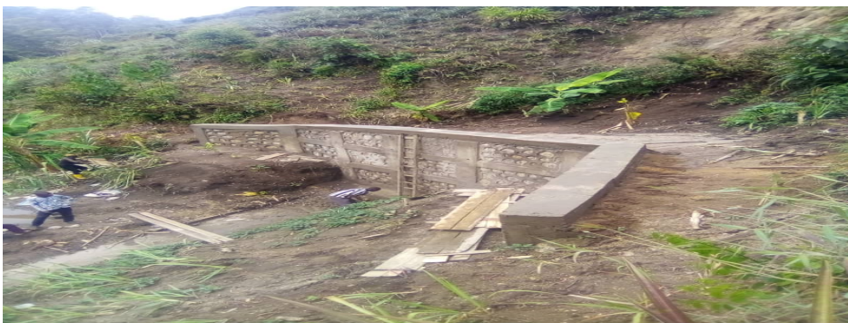
Muro de contención de tierras en manantial Kanyogero
