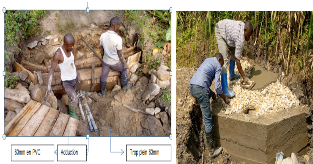
Trabajos de captación de agua en el manantial Combono1: primer caudal 0.605 l/s y segundo caudal 0,18 l/s
