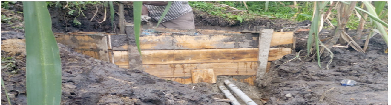
Trabajos de captación de agua en cambono 1: nuevo caudal adicional de 0.2-0.5 l/s
